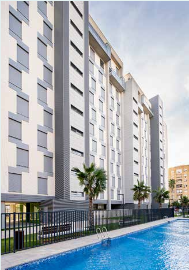
Foto: Edificio de viviendas promovido por Sareb en el centro de Valencia (Comunidad Valenciana).
