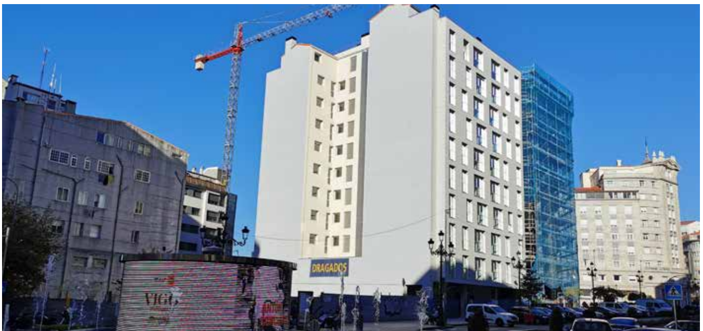
Foto: Primera promoción terminada por Árqura Homes. El edificio se ubica en la Rúa Rosalía de Castro de Vigo (Galicia).
