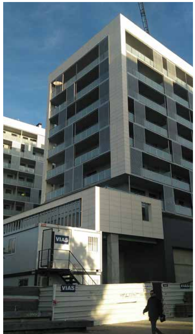
Foto: Edificio de viviendas en desarrollo en Ponent, Badalona (Cataluña).
